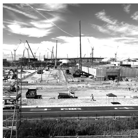
▲ 2024年7月時点の大阪・関西万博会場の工事の様子
